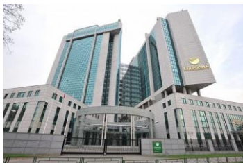
Город: Москва. Объект: ЦОД Дилинг центр в здании ПАО Сбербанк.
